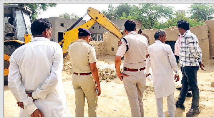
सिरसा। नशा तस्कर सुखदेव पंचायती जमीन पर कब्जा कर अवैध रूप से बनाया गया घर तोड़ी जेबीसी मशीन।
